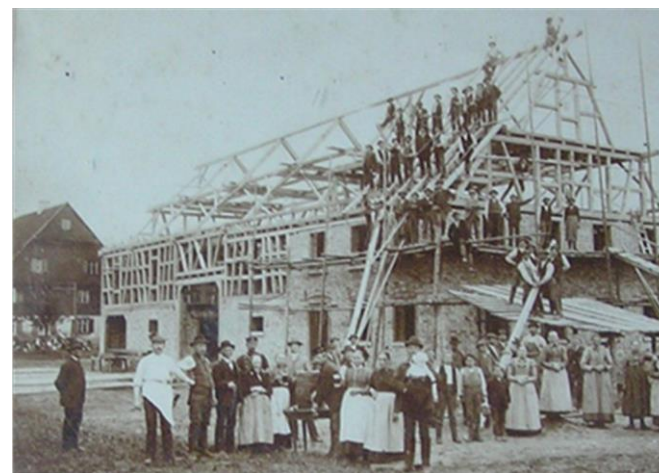
Neubau Hof von Theodor Benkler (1902)
